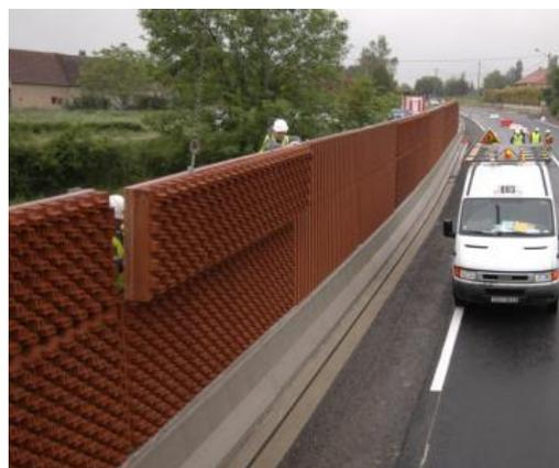
Figure 32 - Photo - Installation d'un mur anti-bruit absorbant les ondes acoustiques - Source : Bruitparif
